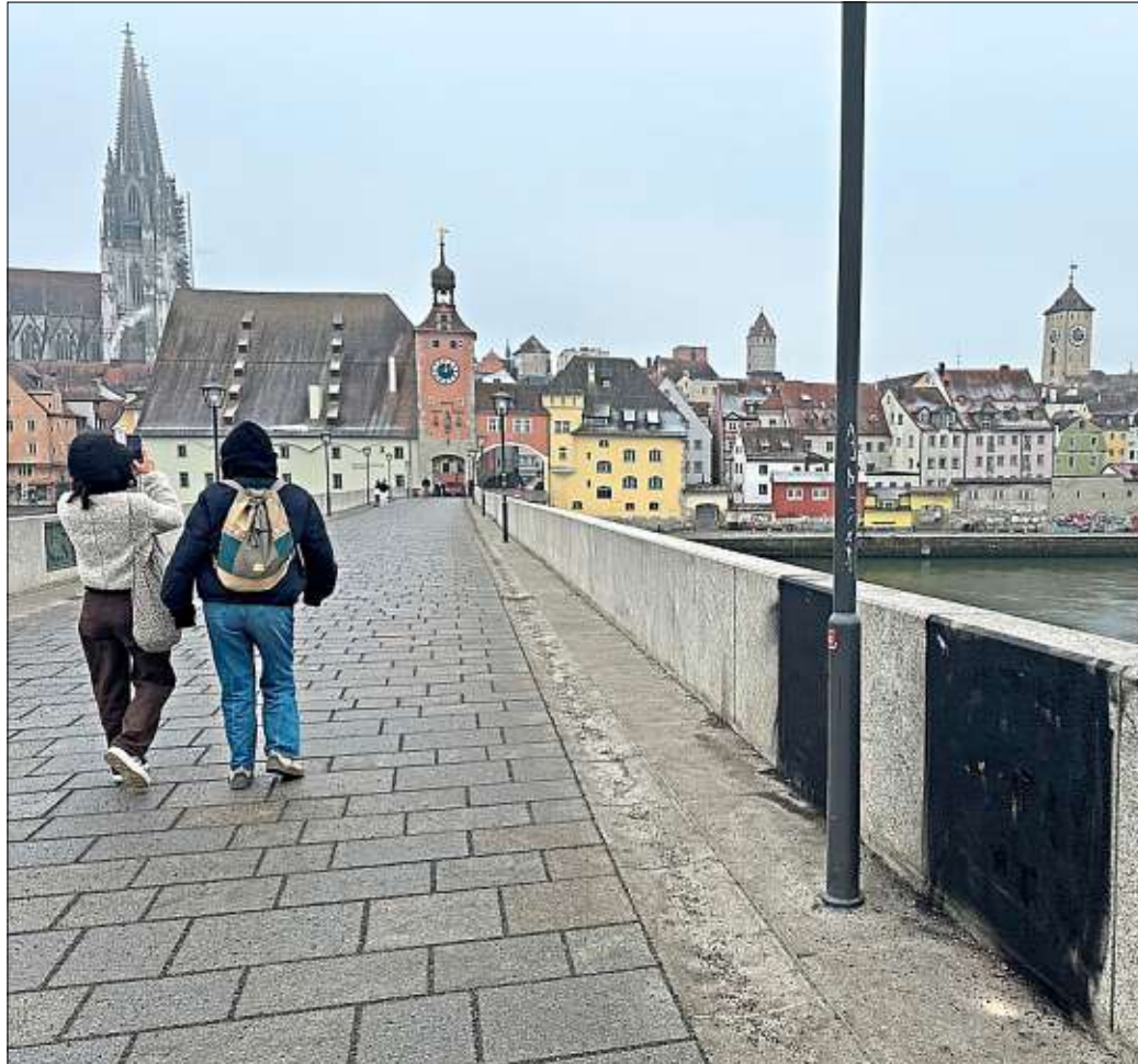
Da muss eine Spezialfirma ran: Das Geländer der Steinernen Brücke wurde besprüht. Foto: Haala
